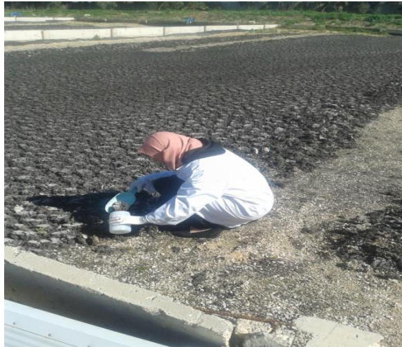
Figure 08 : Le lit de séchage des boues résiduaires
