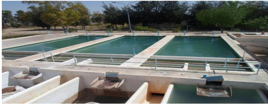
**Figure N°10 : représente les 04 décanteurs de la station de traitement d' Ain Zerga**
