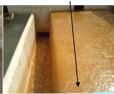
**Figure N°11 : représente l'opération de lavage d'un filtre dans la Station d' Ain Zerga.**
