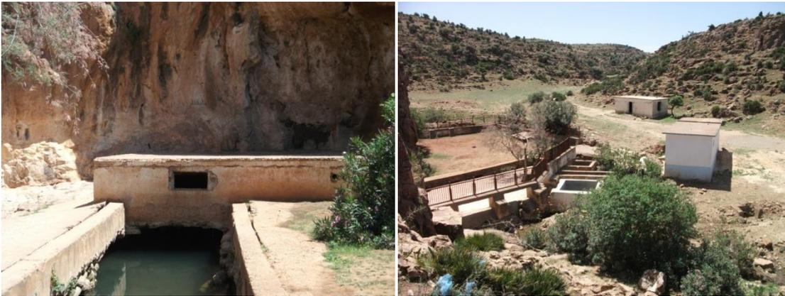
**FIGURE N° 06: Captage délabré de la source d'Aïn Zerga (wilaya de Saïda), et bloc dolomitique karstifié (en arrière plan) à partir duquel la résurgence prend naissance.**
