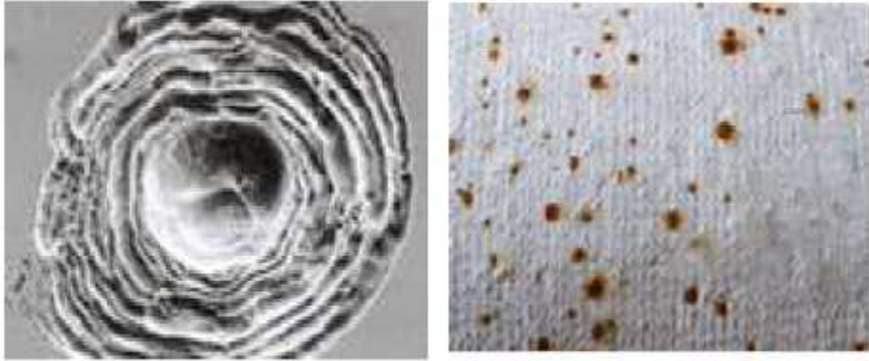
Fig. I.2 Corrosion par piqure
