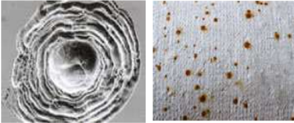
Fig. I. 2 Corrosion par piqure
