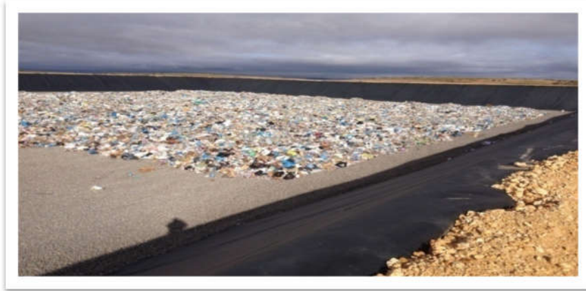
Figure 11 : Remplissage des casiers.
